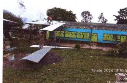
Foto 6: inicio de la sustitución de láminas de las aulas
