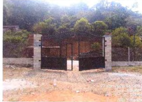
Foto 2: Instalación del portón
