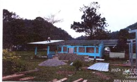
Foto 4: inicio de la sustitución de láminas de la cocina
