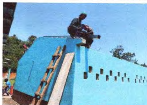
Foto 2: Inicio de la instalación de la estructura
