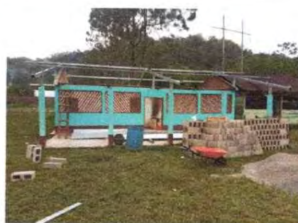
Foto 2: inicio de la sustitución de la estructura de la cocina
