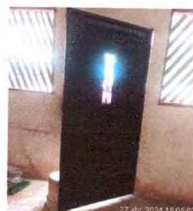
Foto 6: sustitución de puerta de la cocina.
