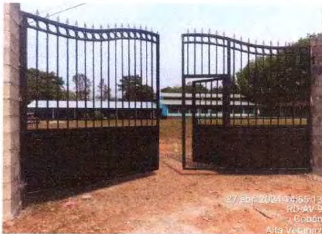
Foto 3: Instalación del portón acceso principal
