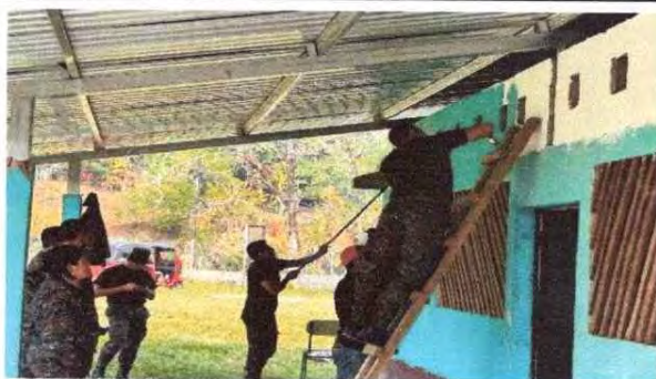
Foto 5: aplicación de pintura en paredes de cocina
