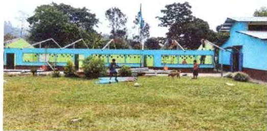
Foto 3: finalización de la instalación de las tijeras de las aulas.
