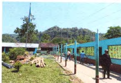
Foto1: Desmontaje del techo y estructura en mal estado
