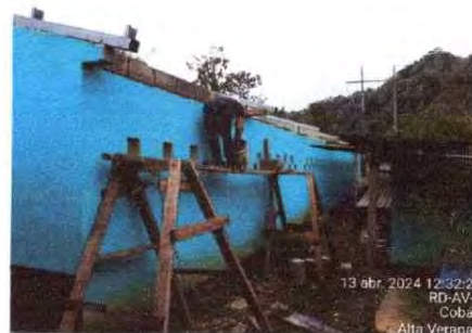
Foto 4: levantado de hileras de block para subir la altura de las aulas
