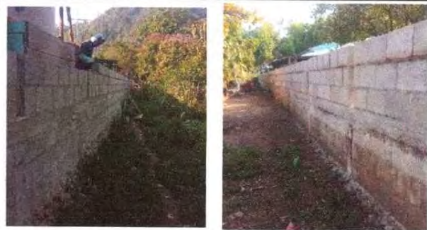
Foto 4: colocación de block en muro perimetral.
