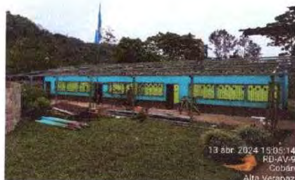
Foto 5: finalización de la instalación de la estructura de las aulas
