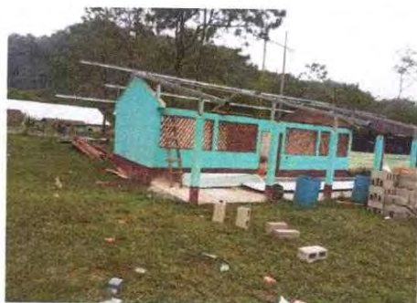
Foto 1: inicio de la sustitución de estructura de cocina
