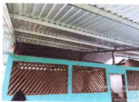
Foto 5: sustitución de las laminas de la cocina
